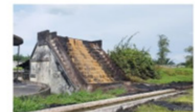
Gambar H. Instalasi untuk sirkulasi Air Limbah PKS Kebun Rambutan
