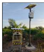
Instalasi prototipe di lahan
